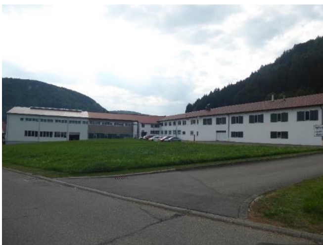
Foto 9: Südlich gelegenes Firmenareal Kessler GmbH
